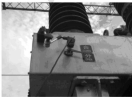
35kV SF6 开关传感器安装
